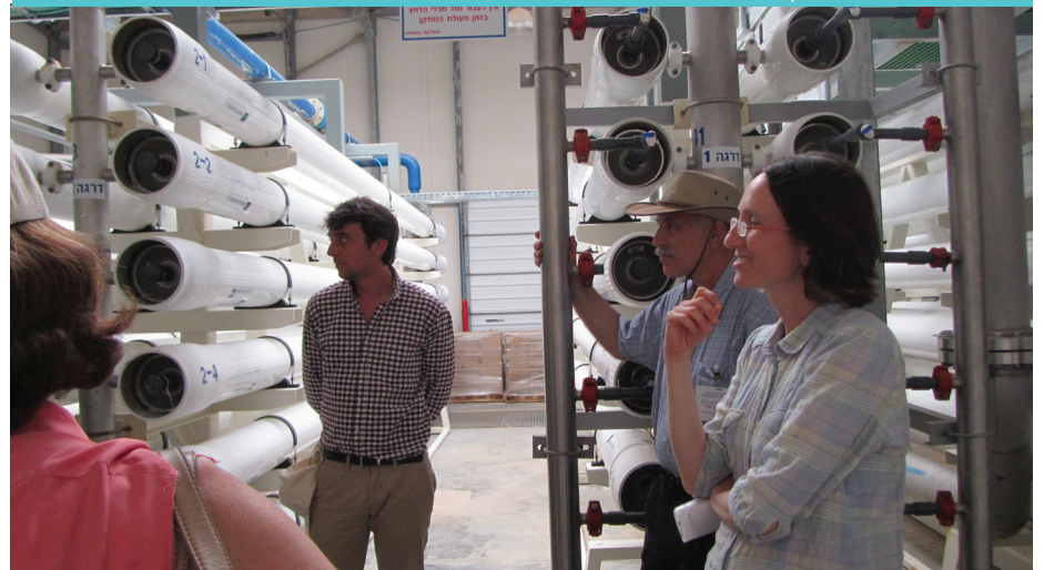
Centrale de désalinisation Ketziof תחנת ההתפלה בקציעות
